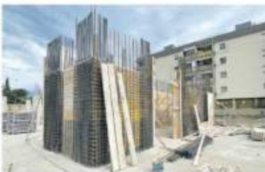
I lavori in corso a San Pio: dove il progetto immobiliare di San Pio per la riqualificazione del centro storico è in corso di attuazione. In alto: la sede del Comune di San Pio.
